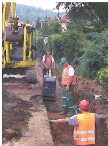
La rue de Philippsbourg est en cours d'aménagement
