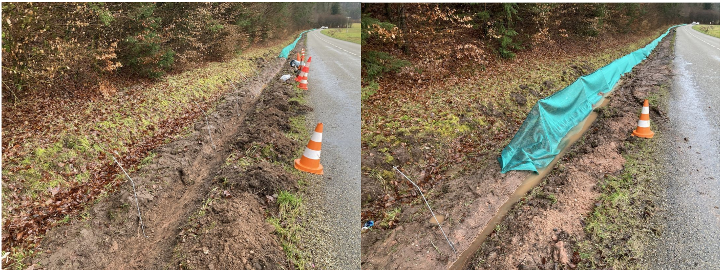
Illustration 2: Dispositif en cours d'installation
